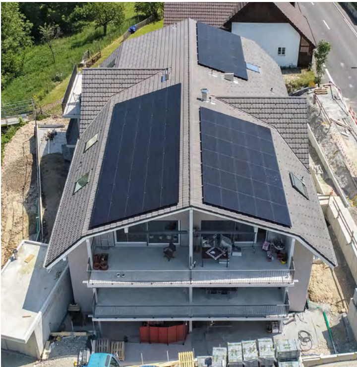
Mehrfamilienhäuser sind ideal für einen Zusammenschluss zum Eigenverbrauch. Jede Partei erhält einen eigenen Zähler und konsumiert eigenen Solarstrom.
