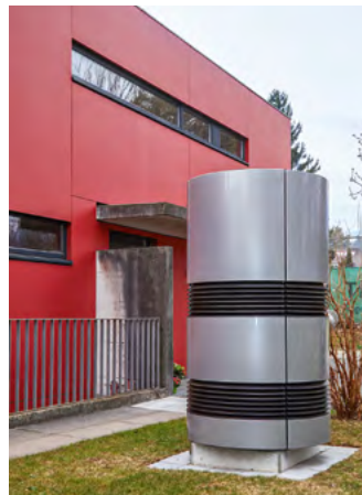
Links: Die PV-Anlage ist nach Ost-West ausgerichtet und erzeugt abends mehr Strom. Rechts: Der Aussenteil der Wärmepumpe. Unten: Künftig könnte die Anlage auch ein Elektroauto laden.
