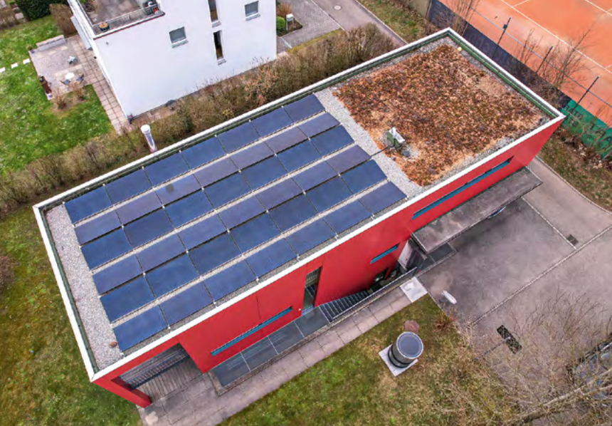
Links: Die PV-Anlage ist nach Ost-West ausgerichtet und erzeugt abends mehr Strom. Rechts: Der Aussenteil der Wärmepumpe. Unten: Künftig könnte die Anlage auch ein Elektroauto laden.
