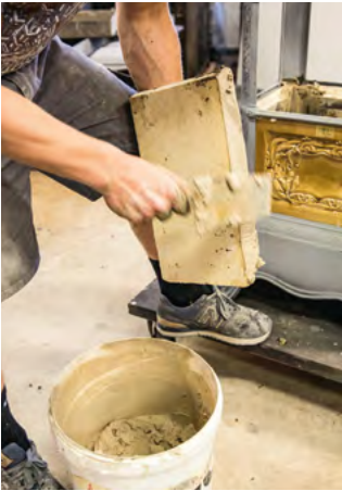
Hafner Joel Schmutz (vgl. Bild unten) mauert einen alten Ofen neu aus. Dann kann dieser wieder während Jahrzehnten die Stube heizen.
